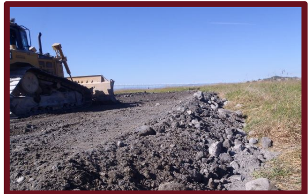
Nivellement et compactage du remblai.
