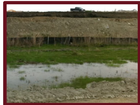
Matériaux de remblayage appliqués en couches minces, avec une clôture anti-érosion à la base du remblai. Le gazon est conservé au bord de la zone de drainage.
