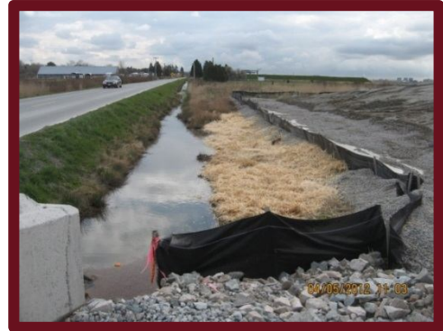
Un paillage, une clôture anti-érosion et du gravier protègent l'eau accumulée dans un fossé.
