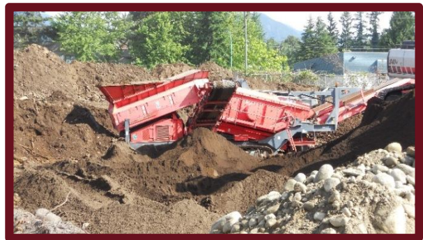
Terre végétale, sable et gravier passés au crible, et sol rocheux.
