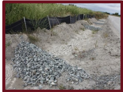
Barrage en gravier dans un fossé de drainage avec une clôture anti-érosion.
