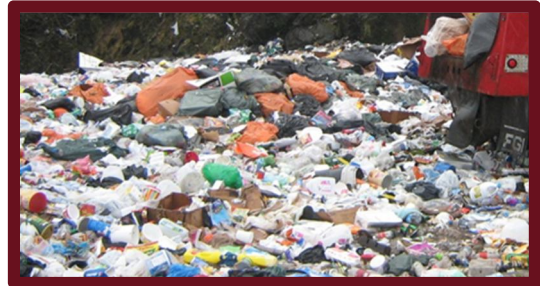
Les déchets ne sont pas acceptables comme matériau de remblayage.
